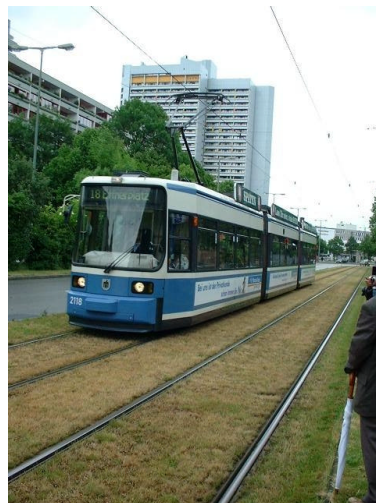
ミュンヘンのL R Tの芝生軌道敷 （芝生により騒音を防ぎ生活環境の改善に役立つ）
