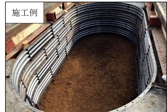
出典：株式会社澤田組 HP「菅田雨水 No.2 小判型立抗築造工」 https://sawadagumi.jp/results/results2/
