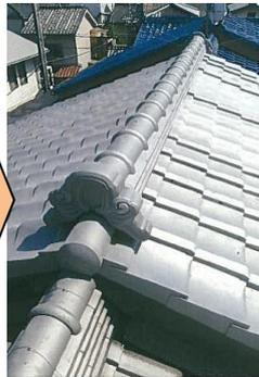
屋根の軽量化（屋根の葺き方を土葺き⇒引っ掛け棧瓦葺きに変更）
