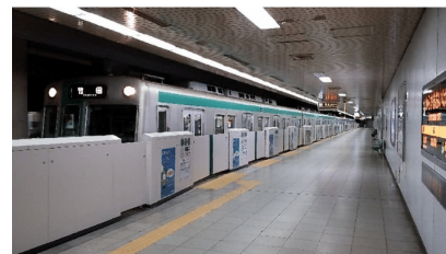
図 3-67 可動式ホーム柵（地下鉄 烏丸御池駅）
