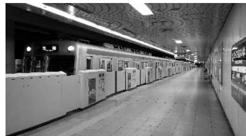
【可動式ホーム柵／烏丸御池駅】
