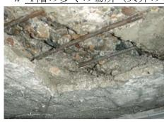
コンクリートの亀裂から長い時間をかけて雨水が浸入した結果、鉄筋に錆が生じ膨張したことにより、コンクリートに亀裂が生じ剥がれ落ち、露筋(鉄筋が露出)した状態となっていた。このままでは建物の耐震性が確保出来ない状態であったことから、鉄筋の錆取り、防錆処理、コンクリートの補修等を行う必要が生じた。
