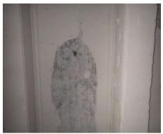
① 天井材を撤去した際に多くの部分で下地材や 仕上げ材等が劣化・損傷していることが判明した。
