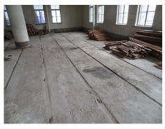
② 床面の仕上げ・下地材を撤去した際に, 床面の不陸(平らでなく凸凹があること。)が 多数判明した。
