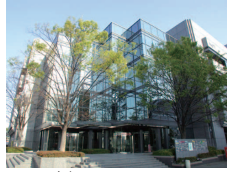
京都リサーチパーク
