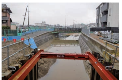
治水工事実施中の河川
