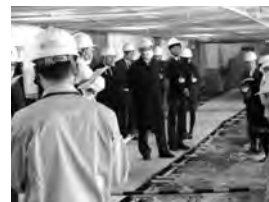
平成29年度 総務消防委員会実地視察 (新庁舎整備工事現場)
