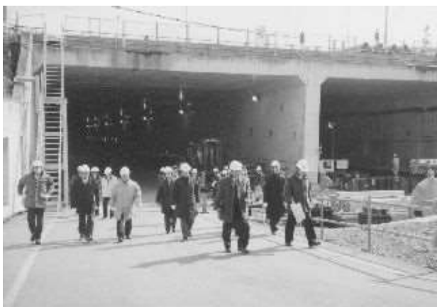
京都高速道路 新十条通及び油小路線建設現場
