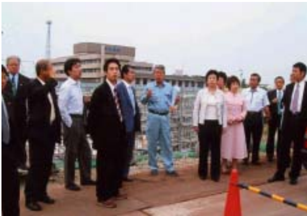
配水地工事現場（富山市）
