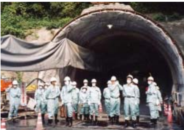
川東第3トンネル（仮称）
