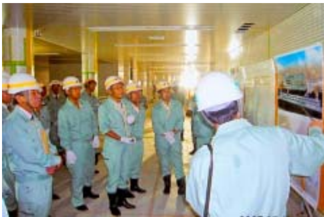
地下鉄東西線太秦天神川駅建設現場
