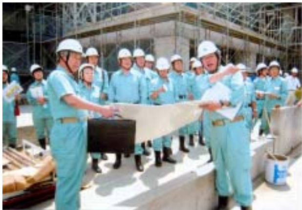
太秦東部地区土地区画整理事業及び太秦東部地区第一種市街地再開発事業の建設現場
