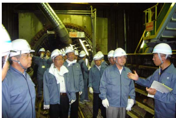
七条西幹線公共下水道工事
