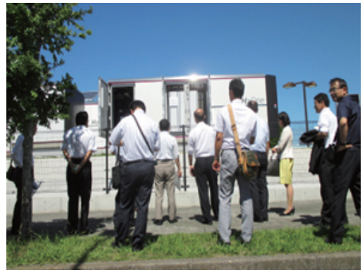
川崎市の自立型エネルギー供給システム
