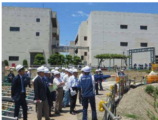
鳥羽水環境保全センター工事現場
