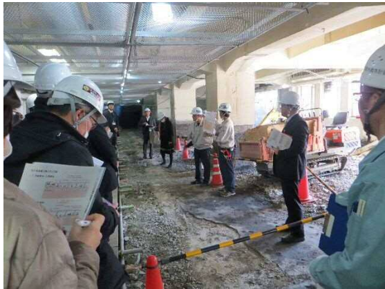
新庁舎整備（本庁舎及び分庁舎（仮称）） 工事現場
