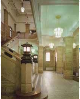
スタンドガラス天井や大理石の階段等、竣工当時の意匠を保存します。
