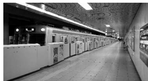
【可動式ホーム柵／烏丸御池駅】
