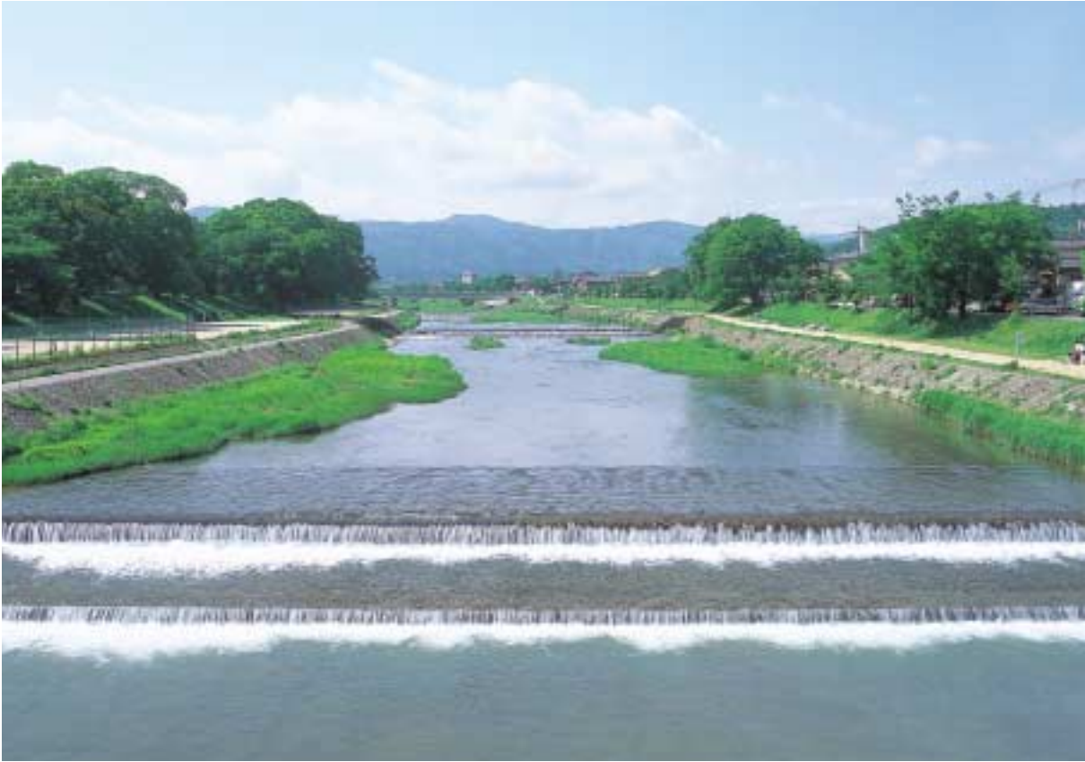
鴨川(賀茂川) [北山大橋上流]
