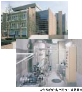
深草総合庁舎と雨水ろ過装置室
