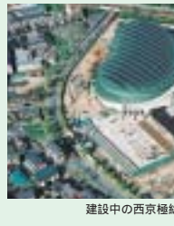
建設中の西京極総合運動公園プール
