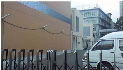
変電所建物(中より奥の建物)
