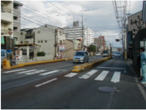
写真 既存の路面電車の停留場 (例：京福電気鉄道嵐山線山ノ内駅)
