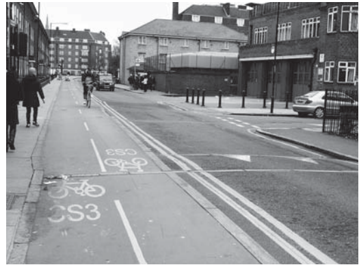
車道を縮小しての自転車道の整備
