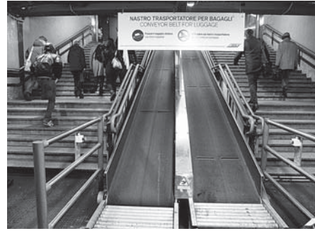
階段と荷物用エスカレーター
