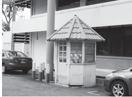
ALSにおける監視小屋
