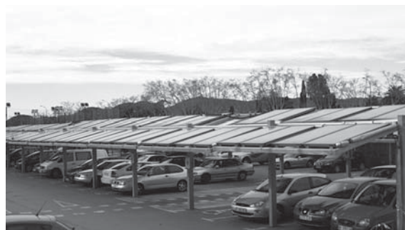
駐車場の屋根にも
