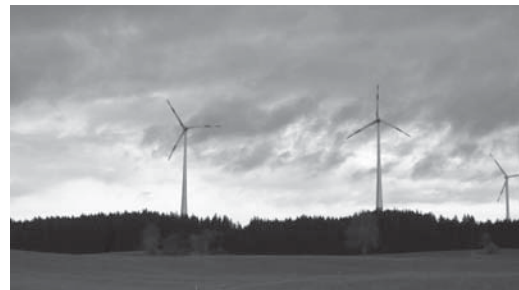
村内にある風力発電施設（市民風車）
