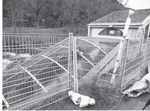
らせん型の小水力発電所
