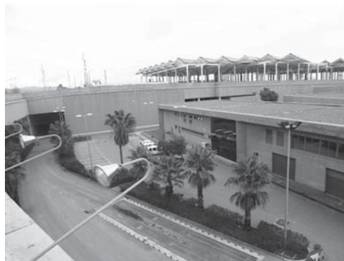
汚水処理施設
