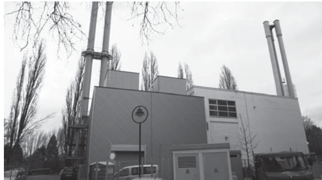
コージェネレーション施設
