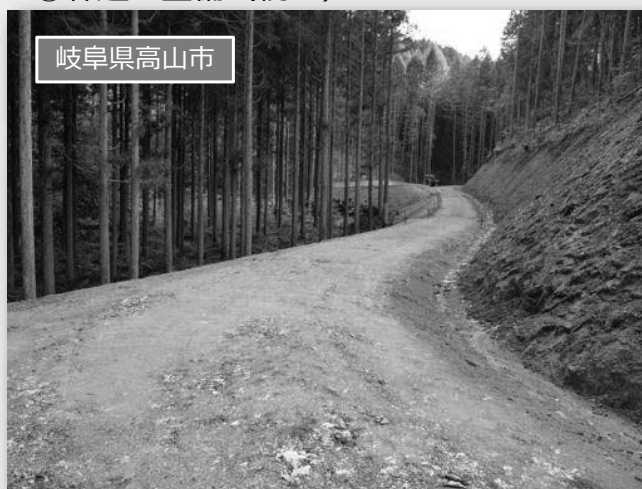
欧州式屋根型構造の作業道（伊西3号線）
