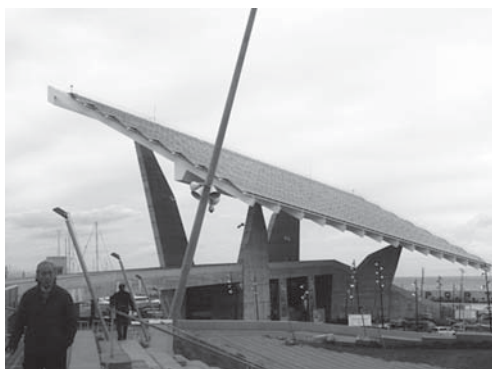
市内中心部にある大規模 太陽光発電施設
